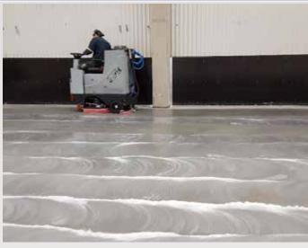
Очистите пол поломоечной машиной с полировальными дисками 320. Начните мойку с примыканий к стенами.
