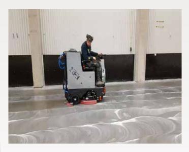
Продолжайте мойку пола поломоечной машиной с полировальными дисками 320 на основной площади.
