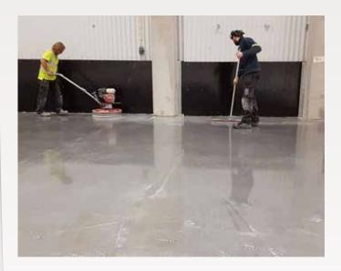
После нанесения Литурин Хард, отполируйте примыкания и кромки с помощью кромочной затирочной машины с полировальными дисками 120/320.
