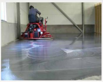
После нанесения Литурин Хард, отполируйте поверхность с помощью полировальных дисков 320.
