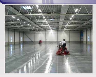
После полировки пола с помощью полировальных дисков 320, должна появиться блестящая поверхность.
